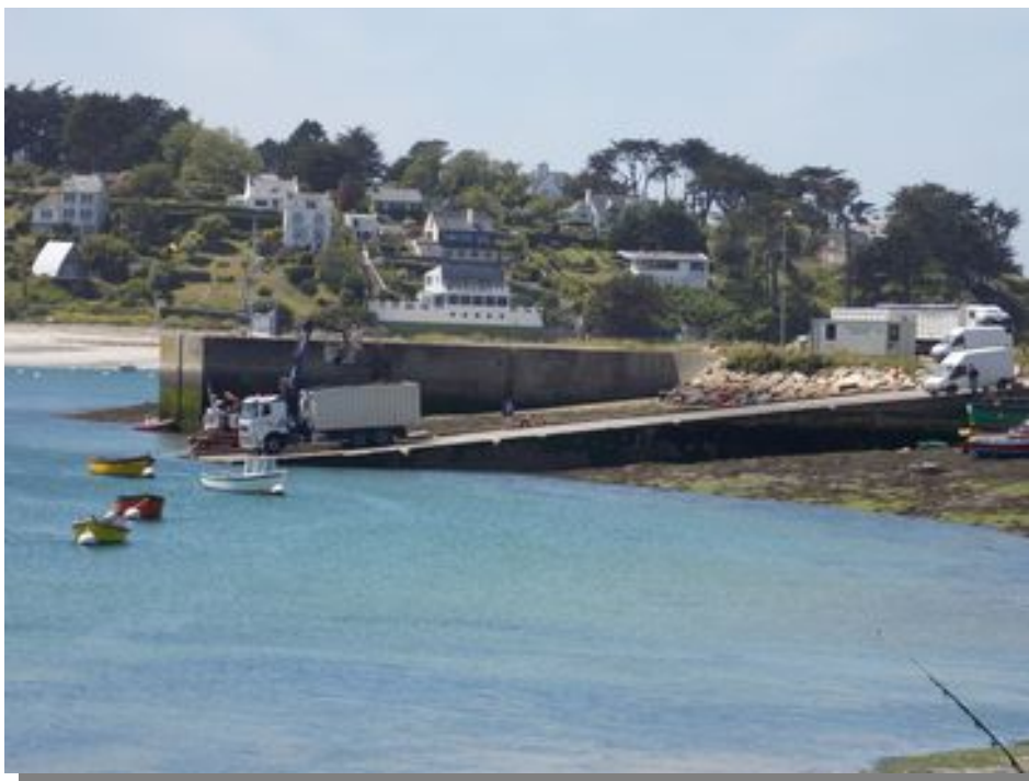
Illustration 31: La cale et le quai du Vilh, toujours utilisés pour le déchargement du goémon
