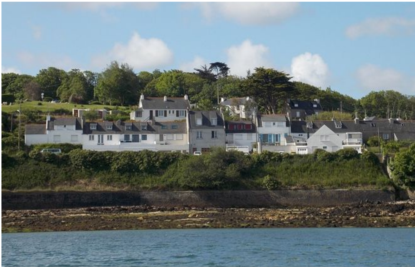
Illustration 27: Les maisons des douaniers vue de la mer
