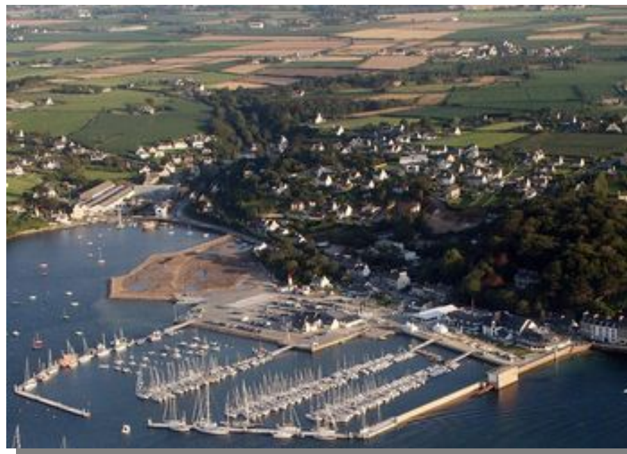
Illustration 35: Le port actuel, après les travaux de 2005-2007
