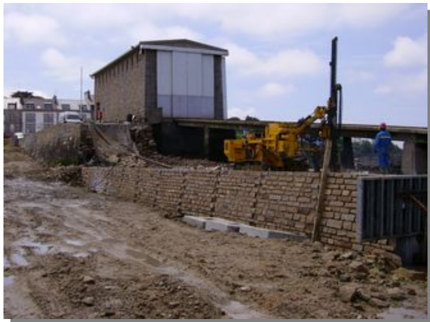
Illustration 36: Construction en 2005 du môle Ouest devant la SNSM
