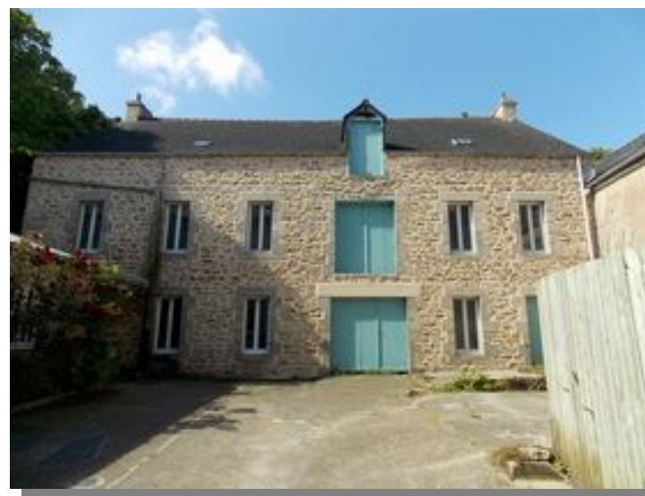
Illustration 43: L'ancien magasin à marée situé sur le Port de l'Aber-Wrac'h
