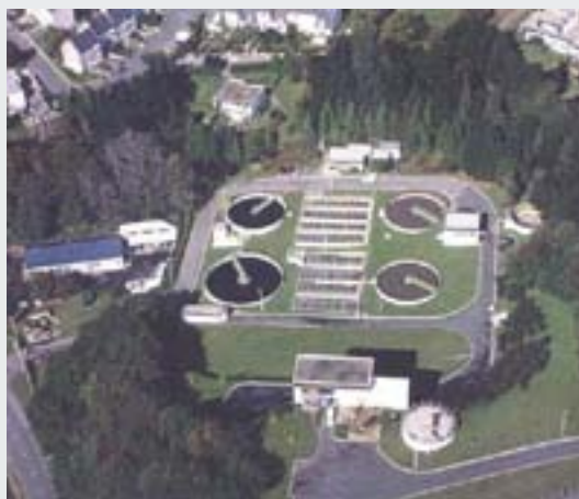
Station d'épuration de Bellevue
