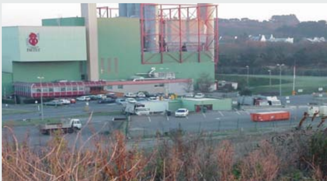
L'unité de valorisation énergétique
