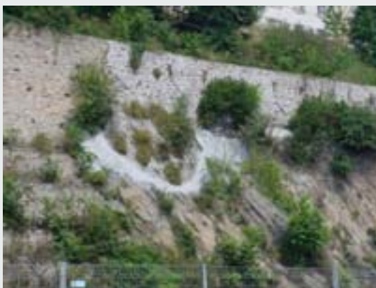
Falaises sécurisées de Poullic al Lor
