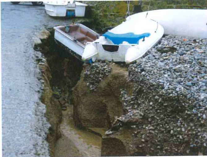
Les orages ont fait quelques dégâts à Porspoder (29) au Port de Mazou.
