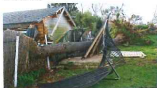
Les deux arbres se sont abattus à côté des maisons.
