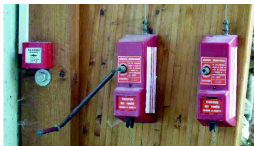
COMMANDE DE DESENFUMAGE (INTERIEUR NORD/OUEST SALLE STREAT KICHEN)
