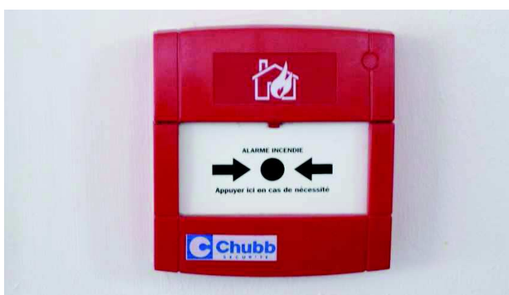
DECLENCHEUR MANUEL D'ALARME
