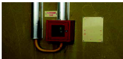
COUPURE COMBUSTIBLE GAZ CHAUFFAGE (EXTERIEUR EST SALLE KERVIGORN)
