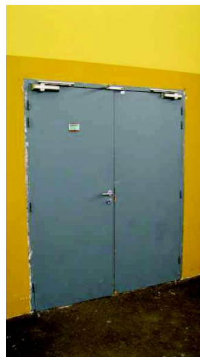
PORTES COUPE-FEU DOTEES DE FERME-PORTE (SALLE KERVIGORN ACCES COULOIR / LOCAL STOCKAGE)
