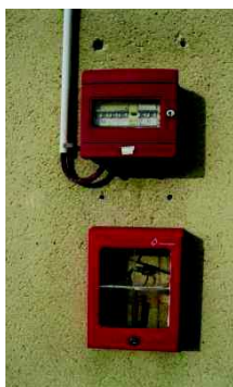
COUPURE DU COMBUSTIBLE CHAUFFERIE FIOUL (EXTERIEUR PIGNON EST SALLE STREAT KICHEN)
