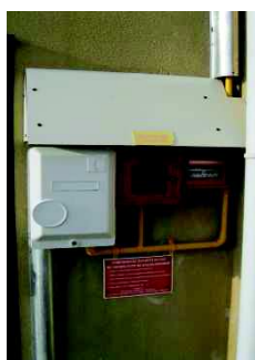
COUPURE DU COMBUSTIBLE CHAUFFERIE GAZ (EXTERIEUR FAÇADE NORD/EST SALLE KERVIGORN)
