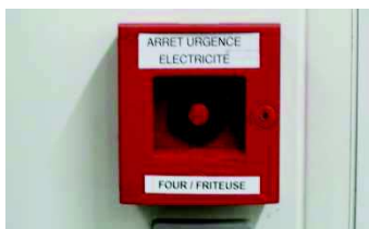
ARRET D'URGENCE ELECTRIQUE FOUR, FRITEUSE
