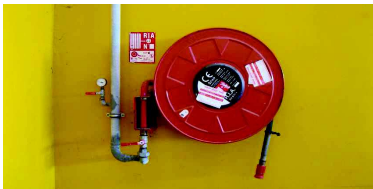
ROBINET D'INCENDIE ARME (INTERIEUR NORD/OUEST SALLE KERVIGORN)
