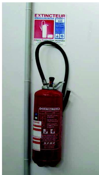
EXTINCTEUR A EAU PULVERISE AB
