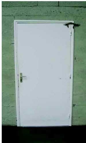
PORTE COUPE-FEU DOTE DE FERME-PORTE (SALLE STREAT KICHEN LOCAL STOCKAGE)
