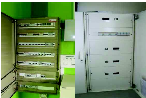
DISJONCTEUR GENERAL / TABLEAU GENERAL BASSE TENSION
