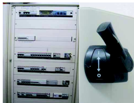
DISJONCTEUR GENERAL / TABLEAU GENERAL BASSE TENSION
