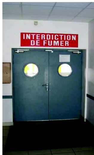
PORTES COUPE-FEU DOTEES DE FERME-PORTE (SALLE KERVIGORN ACCES COULOIR / LOCAL STOCKAGE)
